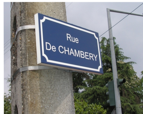
Fixation en angle sur poteau EDF avec collier universel
